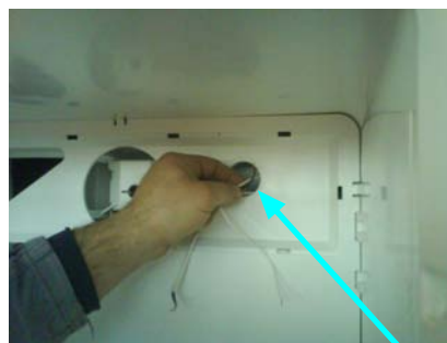
sensor wire out from inspection hole fili recuperati dal foro d'ispezione
